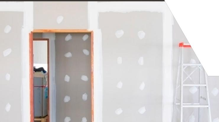
Les cloisons en BA13 peuvent présenter différentes caractéristiques en fonction des besoins chantier : hydrofuges, acoustiques, résistance au feu ou autres
